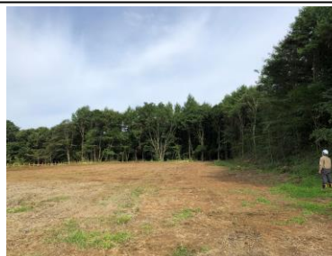
樹木の伐採が終わった建設地
