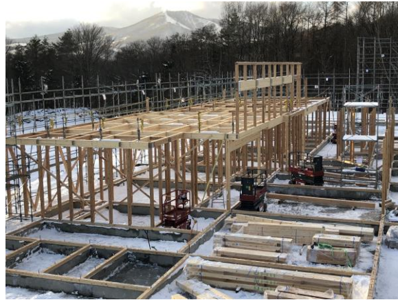
本科教室部分の建て方からスタート (2021 年 12 月 20 日撮影)
